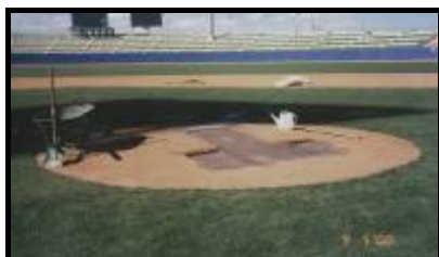
Décaissage du monticule sur l'épaisseur des briques
