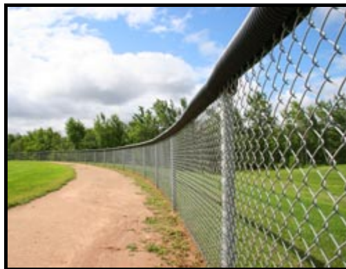
Les poteaux doivent être sur l'extérieur
