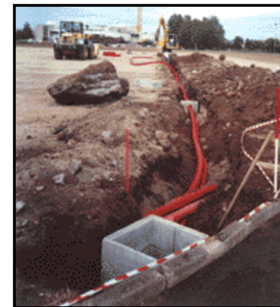
Exemple de drain collecteur
