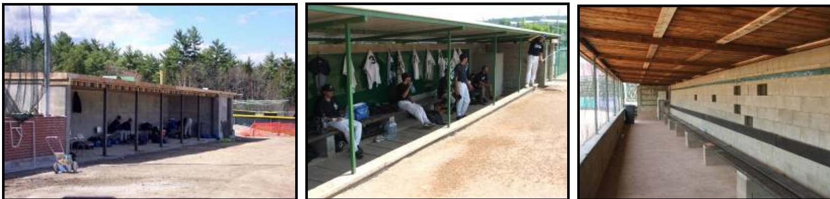
Abris de joueurs au niveau du sol
