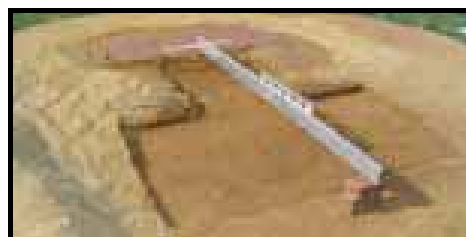
Mise en place d'une règle afin de respecter la pente du monticule
